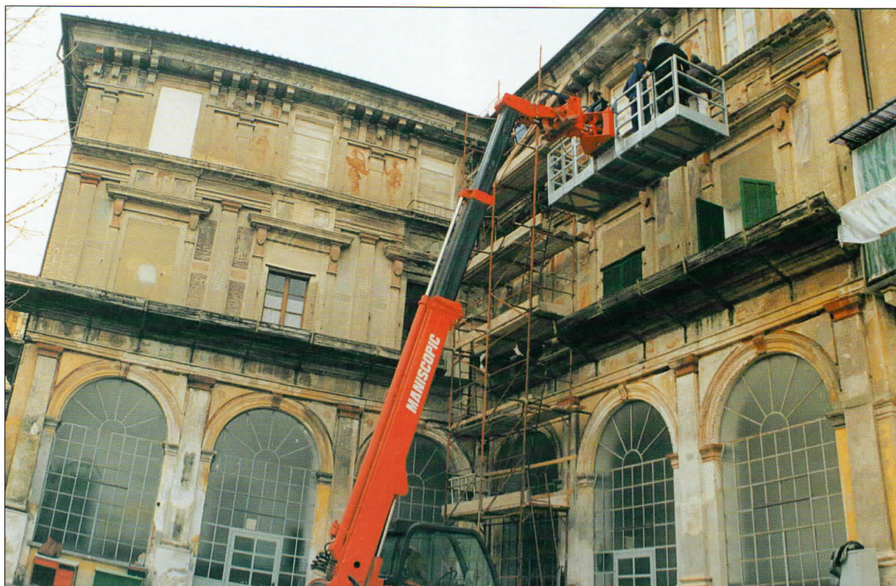
23. Ponteggio fisso per il rilievo della campata-tipo e piattaforma mobile per il monitoraggio delle altre parti di facciata.
