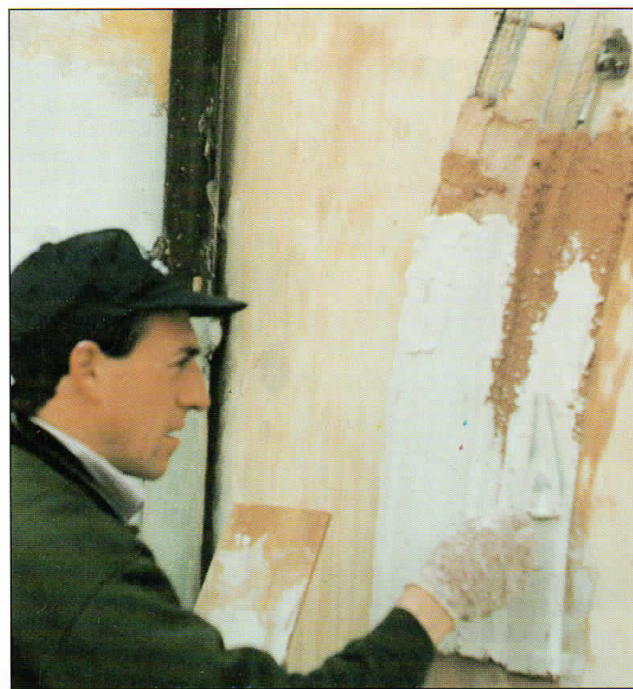
58-61. Realizzazione, sul muro campione, dei modelli tridimensionali delle principali cornici delle facciate del Castello, con il particolare dell'armatura metallica e della dima con cui sono state tirate le cornici.
