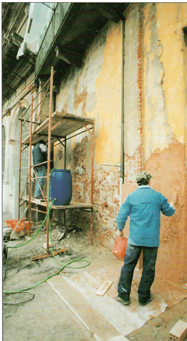
41-42. Preparazione della malta di calce e cocciopesto e applicazione della medesima nella parte inferiore del muro-campione, aggredita dall’umidità ascendente.
