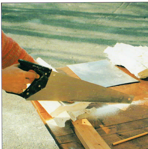
30-31. Rilievo delle cornici col sistema del calco in scagliola, dopo averle isolate con acqua e sapone. 32-33. Sezione del calco e riproduzione del profilo della cornice nella dima in acciaio da inserire nel telaio in legno.
