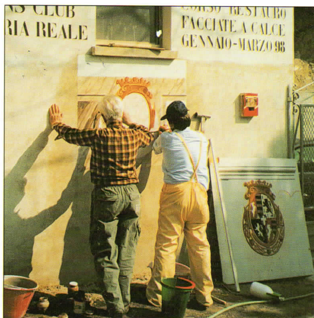
62-66. Realizzazione dell' "insegna" del corso, dalla formazione della scritta con stampini alla stesura dello strato d'intonaco su cui viene dipinto a fresco lo stemma già riprodotto su pannello.
