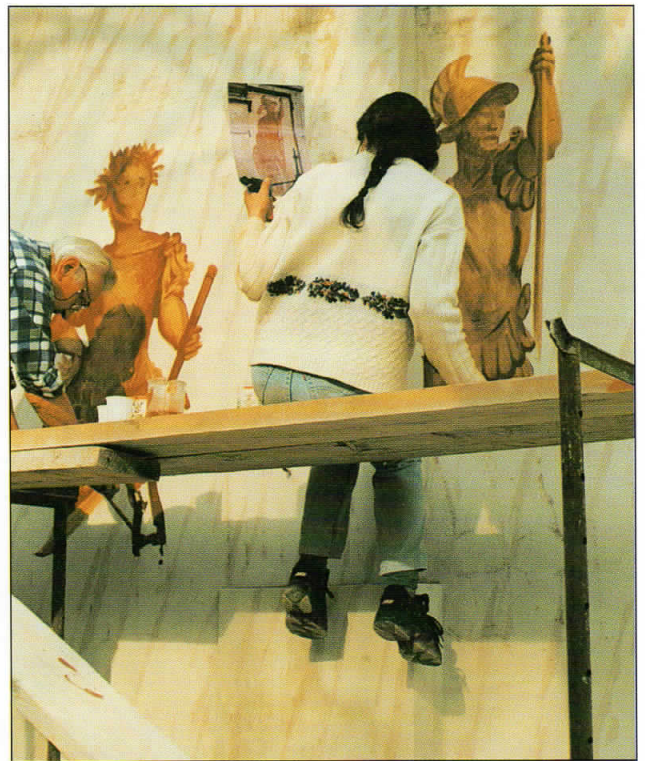
48-50. Particolari delle varie fasi della realizzazione del muro campione con la riproduzione dei decori della campata-tipo del Castello
