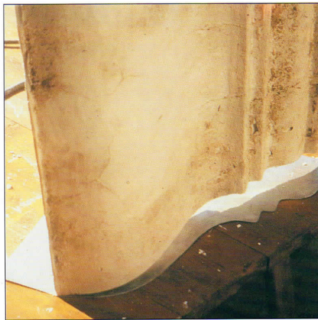
30-31. Rilievo delle cornici col sistema del calco in scagliola, dopo averle isolate con acqua e sapone. 32-33. Sezione del calco e riproduzione del profilo della cornice nella dima in acciaio da inserire nel telaio in legno.
