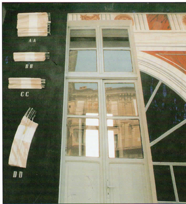
58-61. Realizzazione, sul muro campione, dei modelli tridimensionali delle principali cornici delle facciate del Castello, con il particolare dell'armatura metallica e della dima con cui sono state tirate le cornici.
